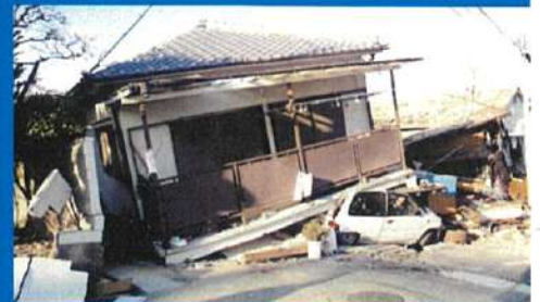
木造家屋の1階部分が崩壊し、2階部分が車を押しつぶしている 丹波市 1995.2.21 The ground floor of a wooden house has collapsed and the upper floor has crashed the car below. Aishiya City. 21 February 1995.
