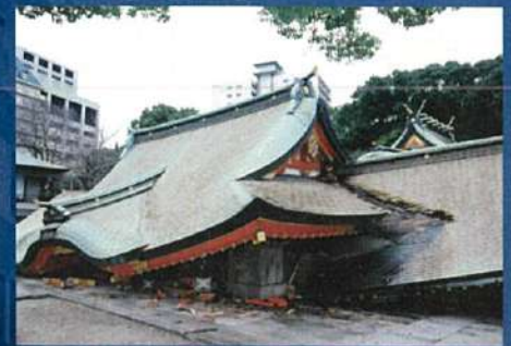
神戸の中心部にある神社も、拜殿が全壊した 神戸市中央区 1995.1.23 A Shinto shrine in central Kobe, also completely collapsed. Chuo Ward, Kobe City. 23 January 1995.
