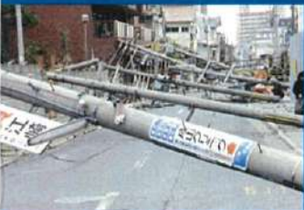
電柱がほぼ水平に倒れ、通行が遮られてしまった道路 神戸市東灘区 1995.1.17 Electricity poles have fallen almost to a horizontal position, blocking the road. Higashi Nada Ward, Kobe City. 17 January 1995.
