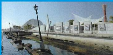
1997.5.19 神戸湾復興宣言。被災したメリケン波止場の一部を保存した震災メモリアルパーク7月完成。写真提供 神戸市 19 May 1998. Kobe Port Recovery Declaration. In July construction began on a memorial park, preserving a region of the destroyed Marikita Wharf. Photo courtesy of Kobe City
