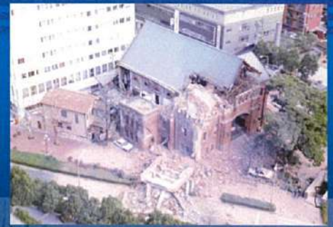
倒壊したゴシック様式の教会堂 神戸市中央区 1995.1.17 Collapsed gothic style cathedral. Chuo Ward, Kobe City. 17 January 1995.
